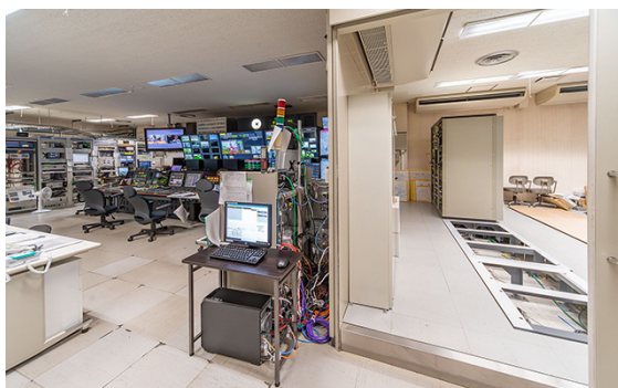
マスタールームに隣接するマシンラック（左写真・右奥）、ラックは従来の5本相当から、2サブ合わせて3本とコンパクトに
