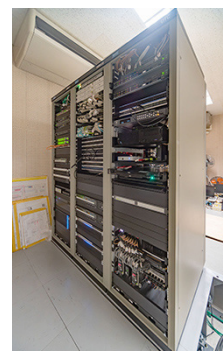
マスタールームに隣接するマシンラック（左写真・右奥）、ラックは従来の5本相当から、2サブ合わせて3本とコンパクトに
